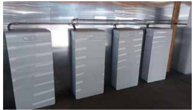
Erweiterung der PV-Anlage /Speicheranlage 150 kWh (Foto: Tischlerei Grüber)
