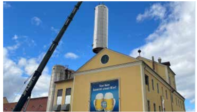
Einbringung des neuen Energiespeichers über eine Öffnung am Dach (Foto: Brau Union Österreich)
